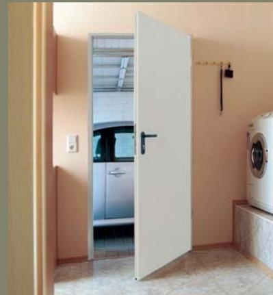
Durch die Brandgefahr ist hier eine Feuerschutztür gesetzlich vorgeschrieben. Sie sollte wegen möglicher Rauchgase zusätzlich rauchdicht sein und wegen der Startgeräusche auch schalldämmend. Und denken Sie mal an die Sicherheit. Wie oft steht tagsüber das Garagentor auf und lädt zum Einbruch ein.
