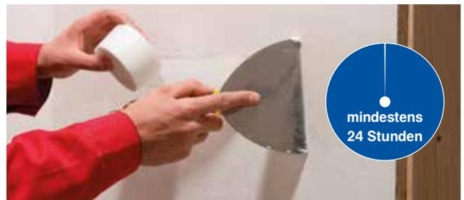
Bild Nr. 6: Versteifungsband - es folgt eine technologische Pause von mindestens 24 Stunden
