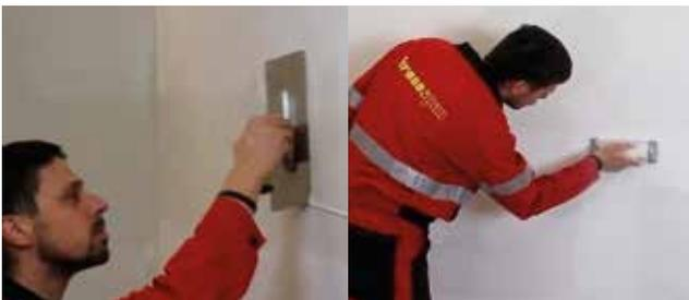
Bild Nr. 7: Deckspachtelung; Schleifen der Spachtelmasse Firestop finish (soweit erforderlich)
