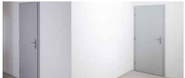
Bild Nr. 8: finale Anpassung - Grundierung (beispielsweise eine Acrylgrundierung) und ein standardmäßiger Innenraum-Maleranstrich
