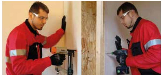
Bild Nr. 4: Plattenbefestigung mit Klammern oder Holzschrauben
