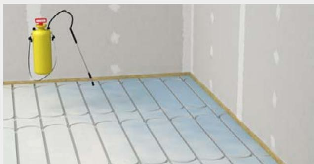
Grundieren der fermacell® Therm25™ Elemente mit fermacell™ Tiefengrund
