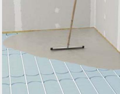
Ausgießen der Therm25™ Elemente mit fermacell™ Ansetzbinder
