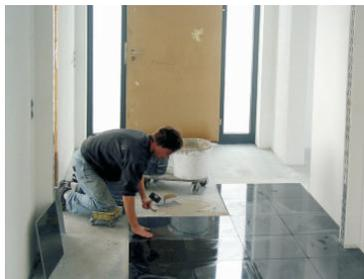
**Mit einem provisorischen Türblatt während der Bauphase lassen sich Feuchteschäden am eigentlichen Haustürblatt vermeiden.
