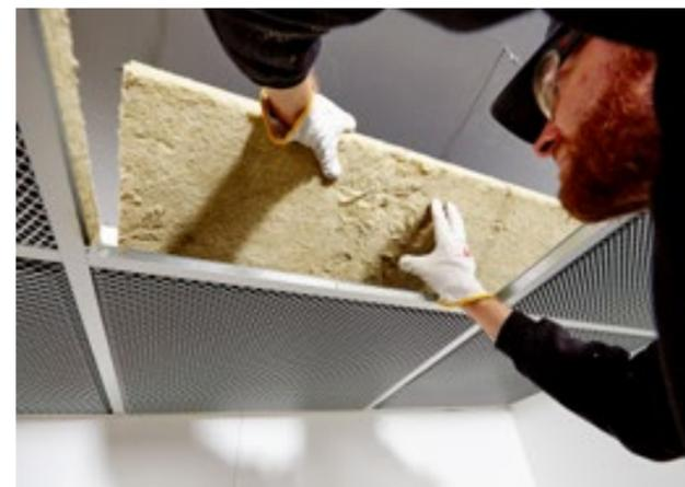
Die **Schallschluckplatte RAF** wird bei mit Vlies oder Folie abgedeckten Akustikdecken eingesetzt.
