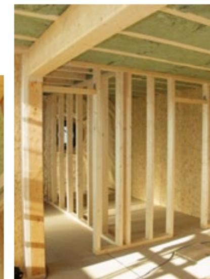
Das vorgefertigte Rahmenwerk einer Innenwand wird erst auf der Baustelle gedämmt und beplankt.
