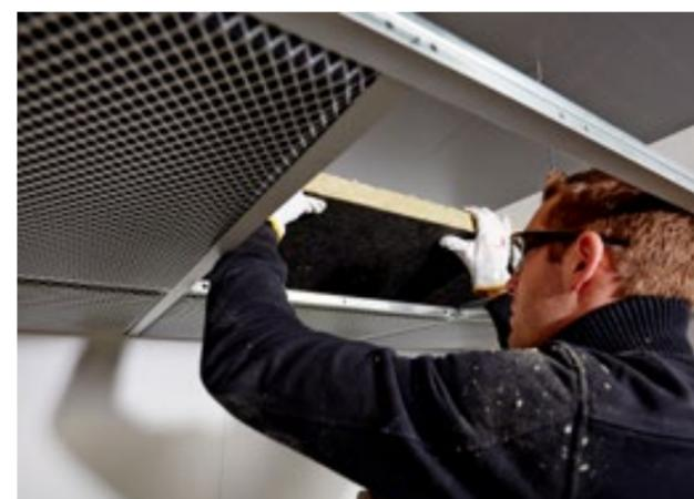
Für gelochte oder geschlitzte Bekleidungen kommt die vlieskaschierte **Schallschluckplatte RAF-SE** zum Einsatz.
