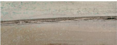
Bei einem Trocknungsprozess können Trockenrisse aufgrund einer nicht gleichmäßigen Holzstruktur entstehen. Je nach Holzart und Standort des Produktes kann dies unterschiedlich stark auftreten und auch wieder vergehen. Trockenrisse sind grundsätzlich zulässig und unbedenklich, da sie die Statik und Haltbarkeit nicht negativ beeinflussen.
