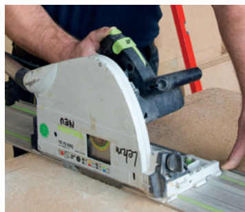
1. Lehmplatten zusägen... mit Stich oder Handkreissäge
