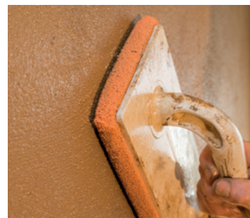
4. Edelputz auftragen... 16 Farbtöne zur Auswahl ca. 7 Tage Trocknungszeit
