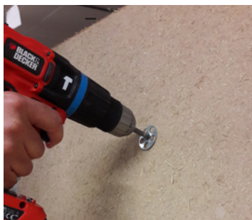
2. Lehmplatten montieren... schrauben, klammern
