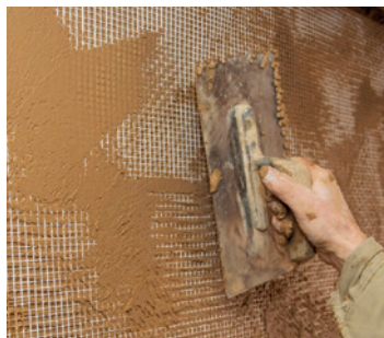
3. Oberputz aufbringen... mit Armierungsgewebe
