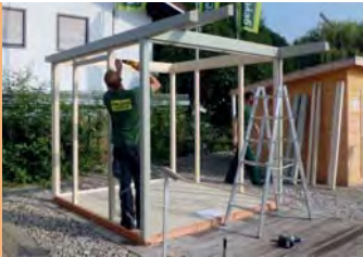
Aufbau der Skelettstruktur
