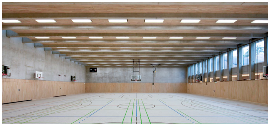
Prallwände und Deckenverkleidung in einer Sporthalle (Arch.: Harter + Kanzler, Freiburg)
