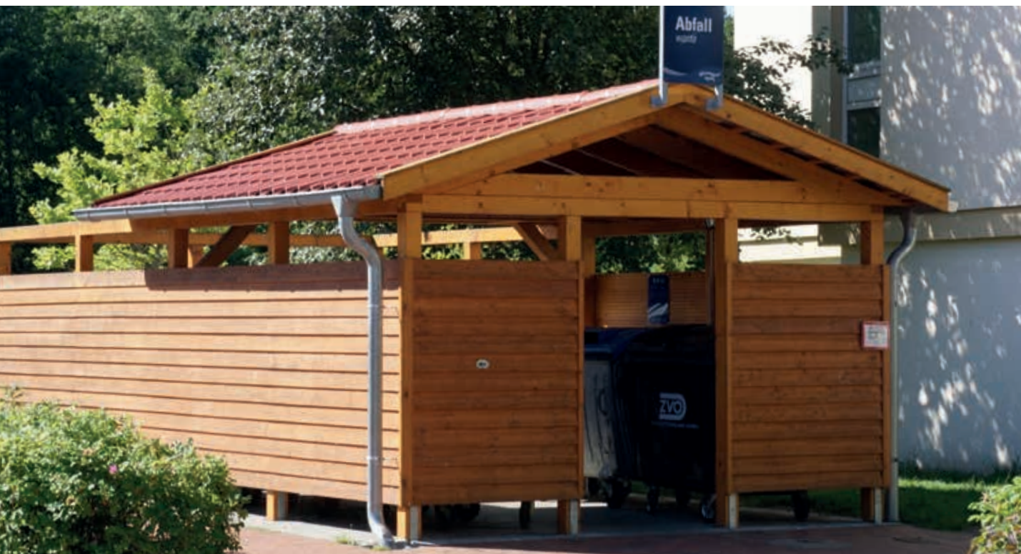
Unterstellplatz für Abfall, hier mit Wänden im Fassadenprofil N+F 28/15 x 141 mm, Lärche naturbelassen – Sondermodell
