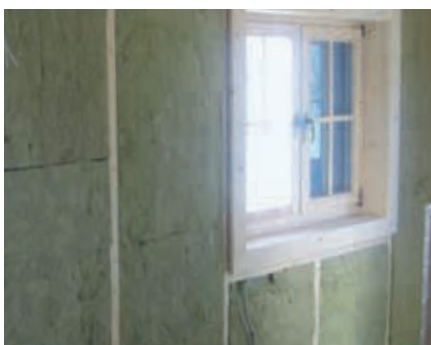
„Winterfest-Option“: doppelschalige Außenwand mit innenliegender Dämmung
