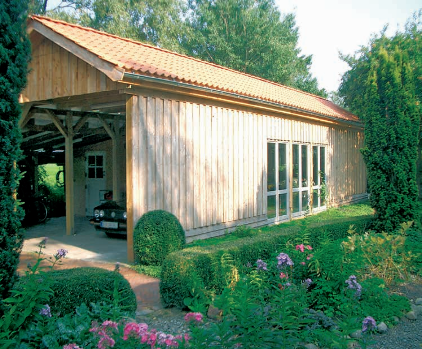
Satteldach-Carportlösung mit individueller Wandgestaltung (sogenannter „Boden-Deckel-Schalung“)
