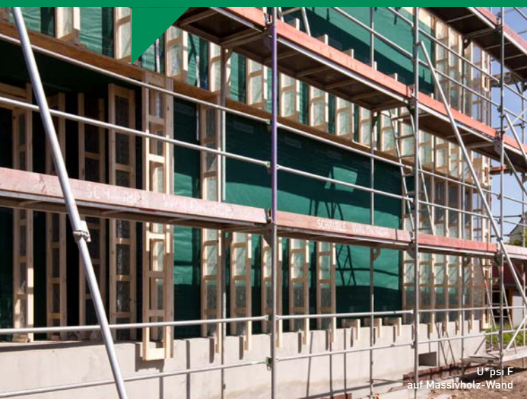
U*psi F, eingesetzt als Kontersparren
