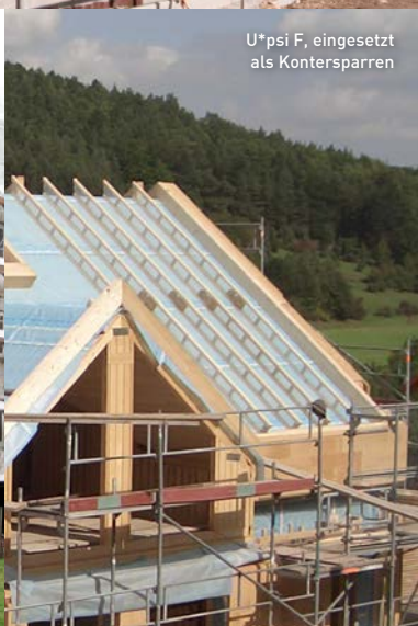
U*psi F auf Massivholz-Wand
