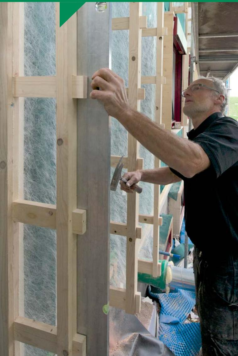
Die energetische Modernisierung von Massiv- und Holzbauten bis hin zum Minergie-P- und Passivhaus-Standard wird jetzt ganz einfach: Lignotrend hat den wärmebrückenminimierten Dämmständer U\*psi gezielt für die Sanierung weiterentwickelt.
