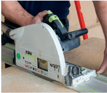
1. Lehmplatten zusägen... mit Stich oder Handkreissäge
