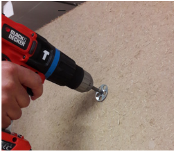
2. Lehmplatten montieren... schrauben, klammern
