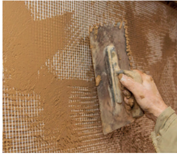
3. Oberputz aufbringen... mit Armierungsgewebe
