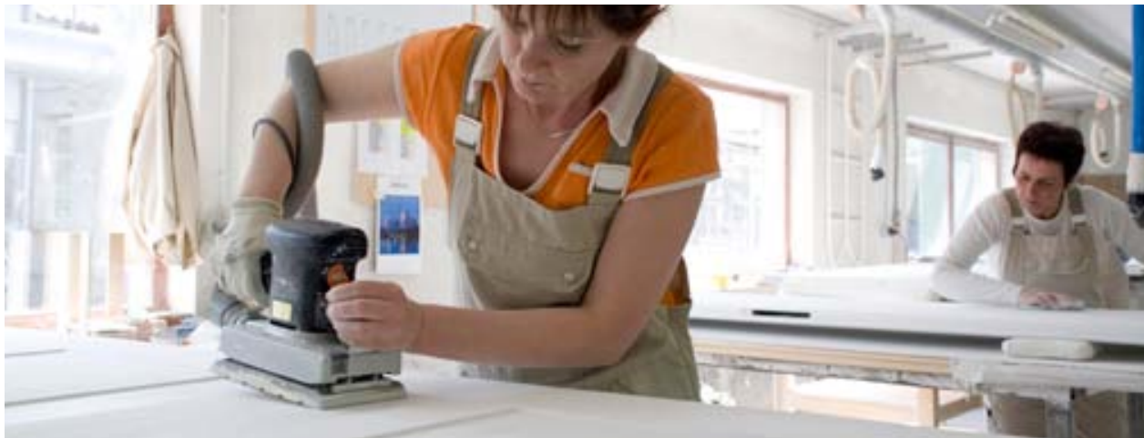
3. Schritt – Zwischenschliff
