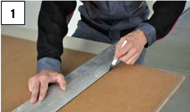
Schnittlinie abmessen & anzeichnen
