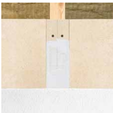
Hydropanel auf Holz-Unterkonstruktion
