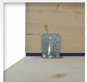
Gemessener Aufbau mit Winkelverbinder und Schrauben
